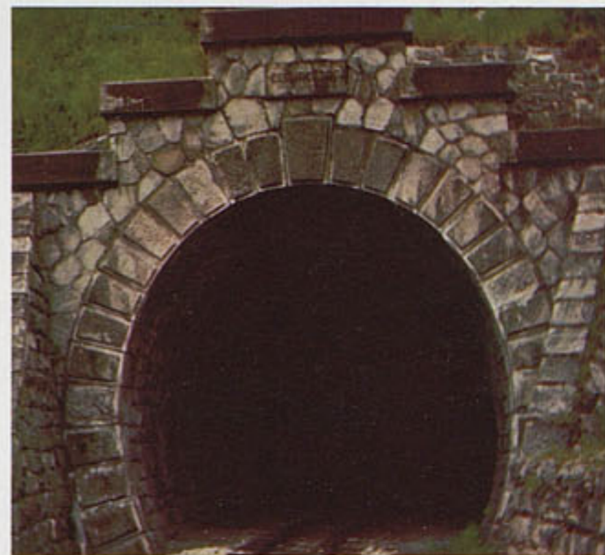
B 810 2 Tunnelportale mit abknickbaren Flügelmauern. 2 Tunnel Portals. 2 Entrées de tunnel. 2 Ingressi galleria.
