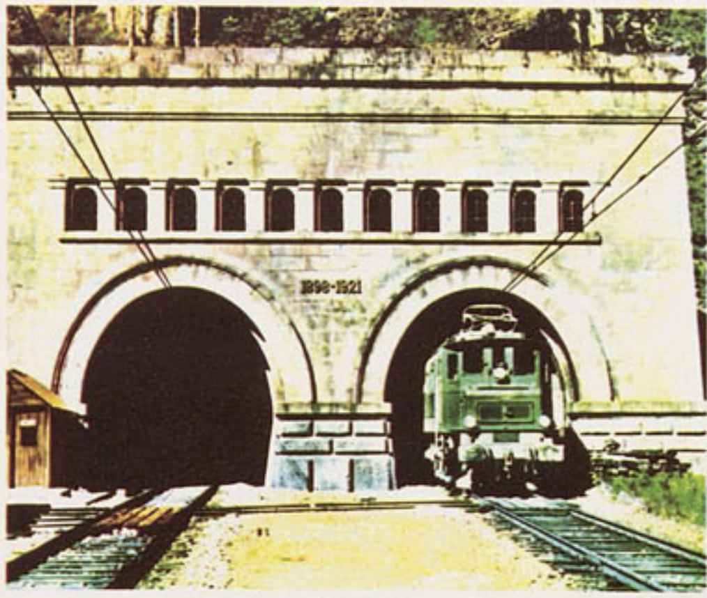
B 271 Tunneleinfahrt „Simplon-Süd“. Simplon Tunnel Southern entrance. Entrée Tunnel „Simplon“. Ingresso Galleria Sempione Sud.
