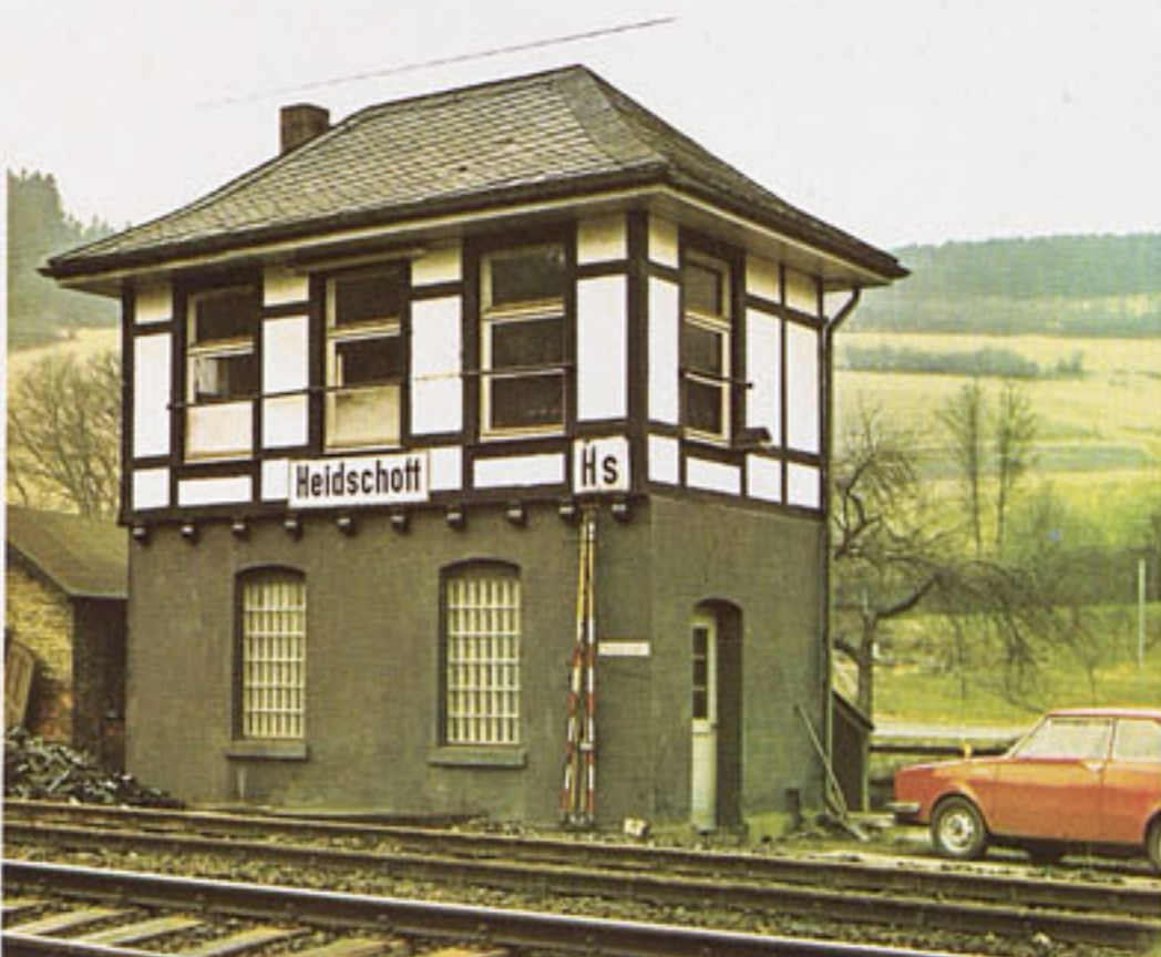
B 216 Stellwerk „Heidschott“. An attractive signal box. Poste d'aiguillage type ancien. Posto di blocco.
