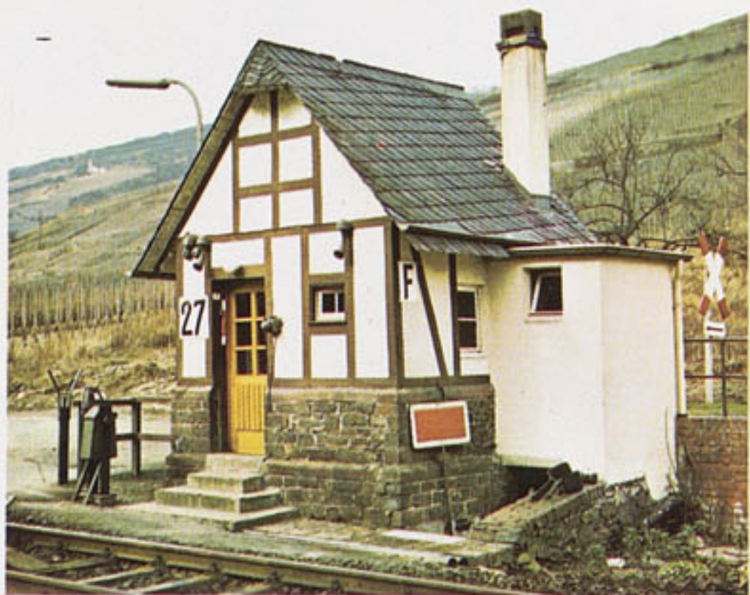
B 218 Bahnh. Level Crossing Keeper's House. Maison de garde-barrière, avec manivelle. Casello ferroviario.
