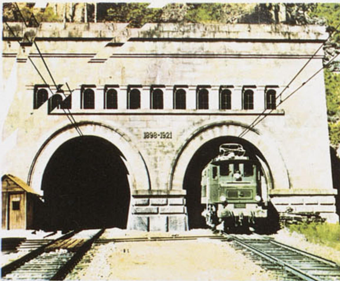
B 271 Tunneleinfahrt „Simplon-Süd“. Simplon Tunnel Southern entrance. Entrée Tunnel „Simplon“. Ingresso Galleria Sempione Sud.
