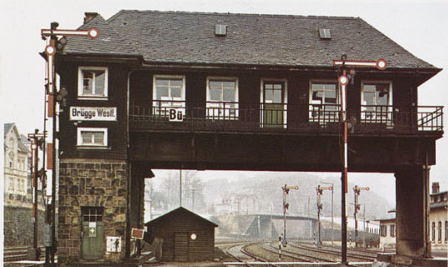
B 215 Stellwerk „Brügge“. Signal box will span up to 3 tracks. Poste d'aiguillage. Posto di blocco.
