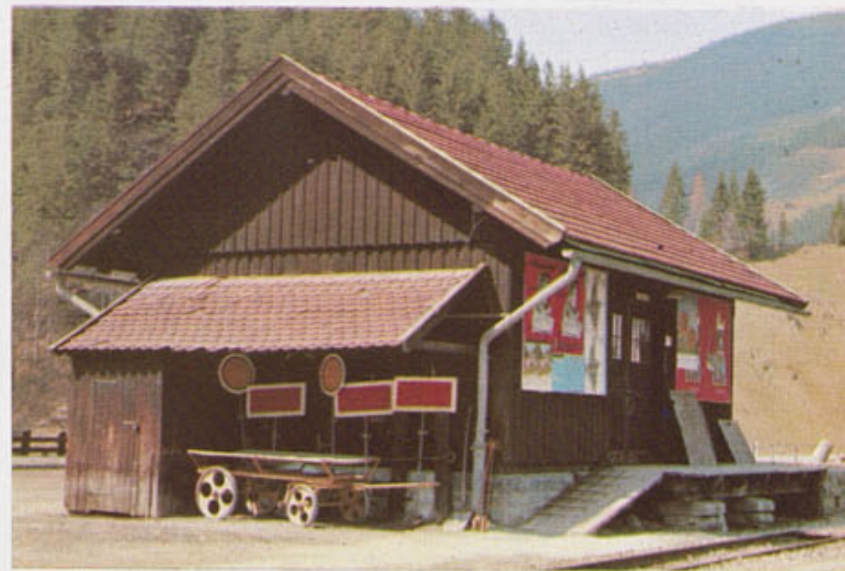
B 802 Güterhalle „Krimml“. Country goods shed. Hangar de marchandises. Magazzino ferroviario.
