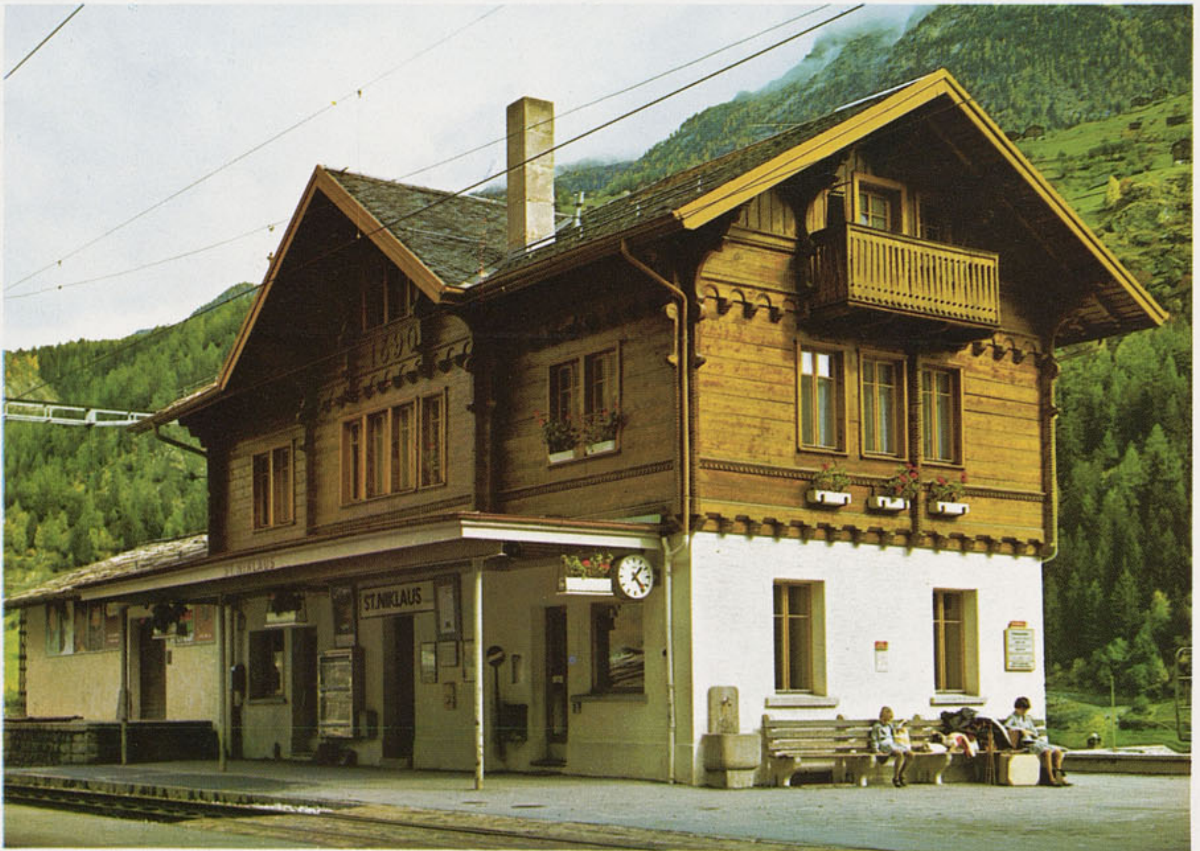
B 200 Bahnstation St. Niklaus. Ein herrlicher Bahnhof, ausgestattet mit sehr vielen Details. An der linken Seite angebaute Güterhalle mit Prellbock. Das Original dieses Modells befindet sich in der Schweiz an der Bahnlinie Visp-Zermatt.
