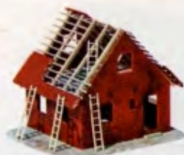
Casa in costruzione quasi ultimata.
