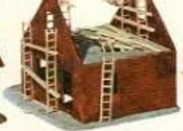
Casa in costruzione
